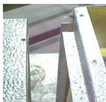
Section du ventilateur (gauche) et haut du serpentin (droite) avec fente de 3/4 po.
