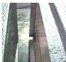
Section du ventilateur (gauche) et dessous du serpentin (droite) avec fente de 3/4 po.
