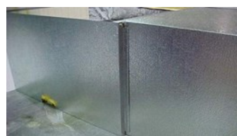
Arrière du serpentin HD (gauche) connecté à un ventilateur (droite).
