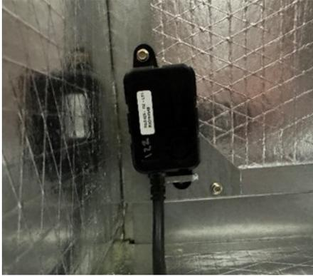
2. Localisez la découpe sur le panneau de la bobine et retirez-la. Installez le passe-fil fendu et acheminez le câble du capteur à travers le panneau.
