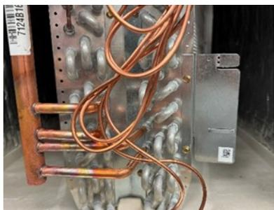
1. Insérez le capteur dans la fente avec le câble acheminé vers le bas, puis pliez la languette supérieure ou installez la vis fournie comme indiqué ci-dessous pour verrouiller le capteur en place.
